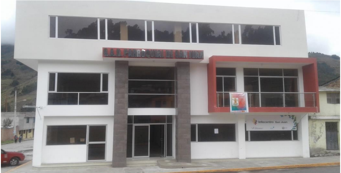
Gráfico 2: Instalaciones del GAD San Juan
