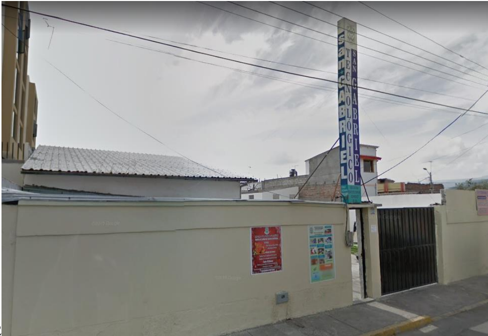
Imagen 2. Instalaciones Instituto Superior Tecnológico San Gabriel
